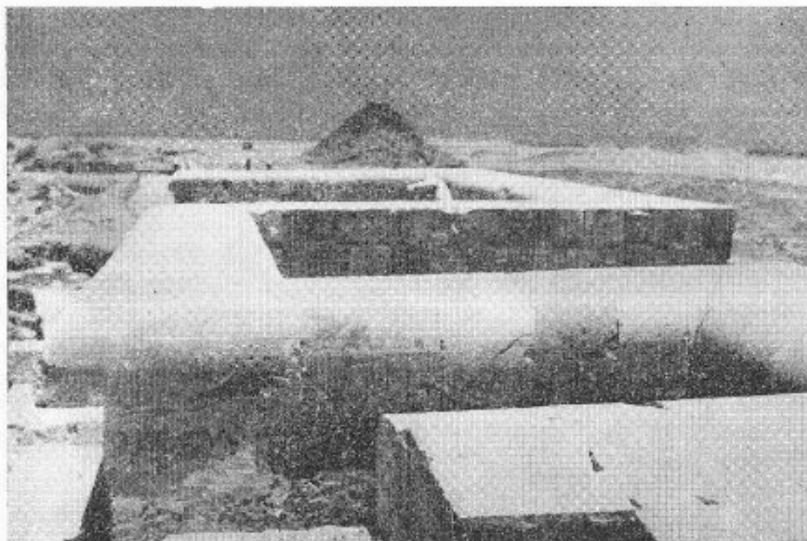
Fig. 1 - Le parapet du chemin de ronde en cours de reconstitution.
