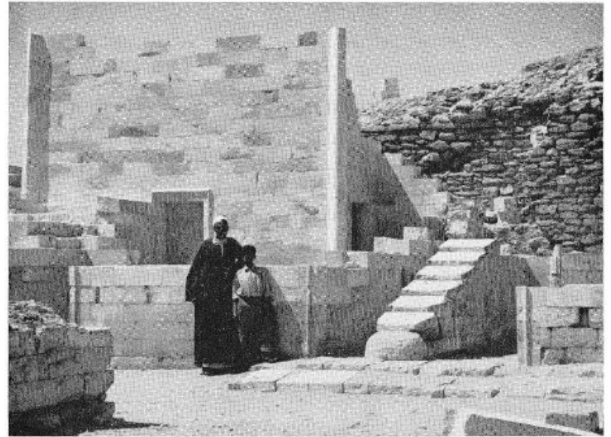
A - Pavillon à tores d'angle en cours d'anastylose, façade principale.
