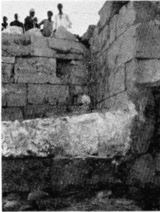
Fig. 2 — Reste de chaux dans un magasin du temple de Pépi I, utilisé comme four à chaux.
